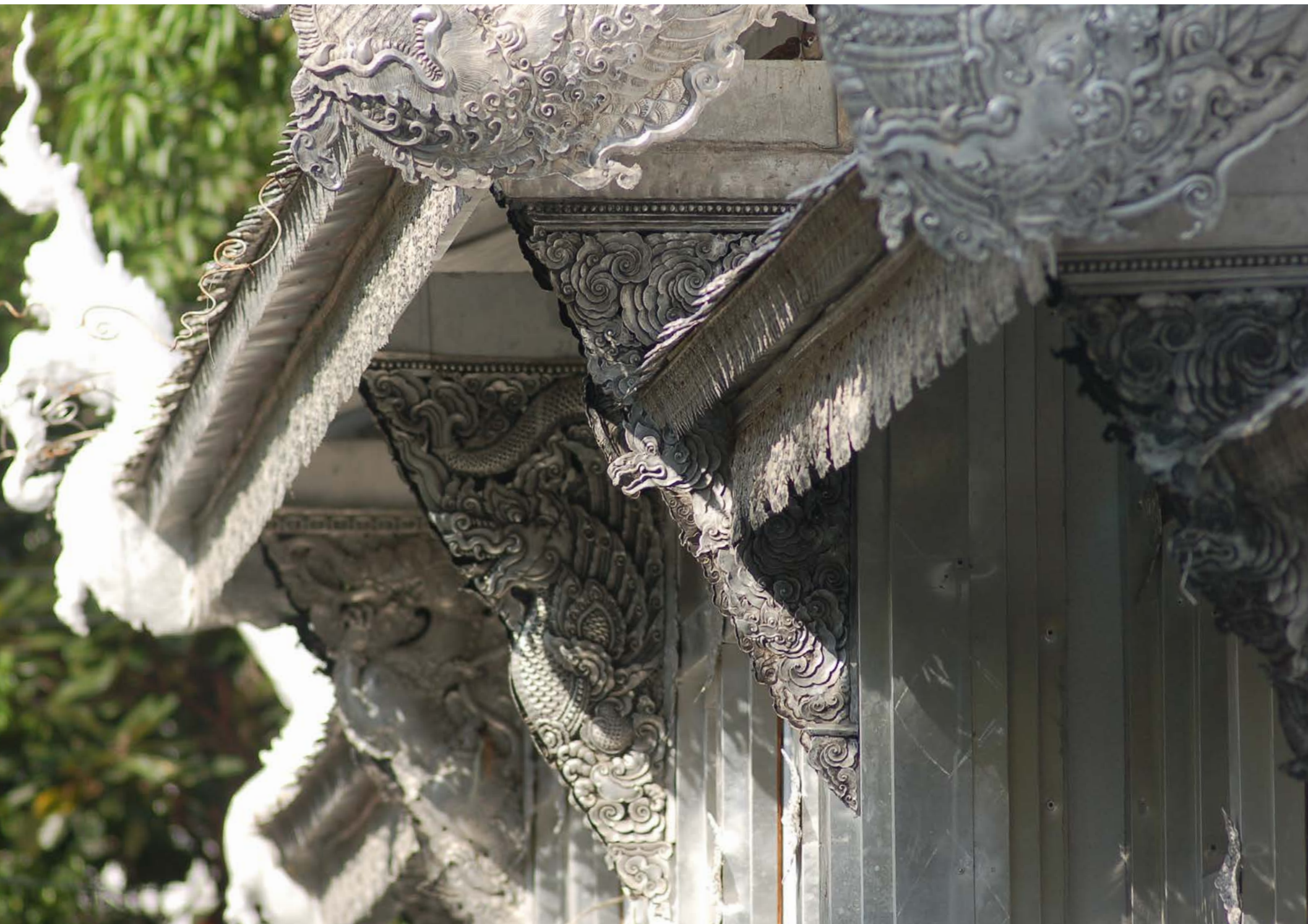
พระอุโบสถ วัดศรีสุพรรณ เป็นอุโบสถเงินหลังแรกของโลก สร้างด้วยการก่ออิฐถือปูน แต่เปลี่ยนจากการประดับปูนปั้นและเครื่องไม้เป็นการดูลายบนแผ่นโลหะ The Ordination Hall, Sri Suphan Temple in Chiang Mai, is the first of its kind to be gilded in silver. The interior decoration of cement and wood has been replaced by silver embossing.
